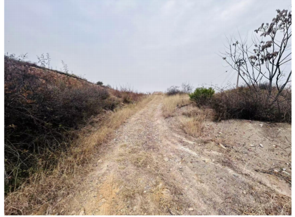
改建道路现状
