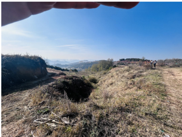
1#风机风机平台现状
