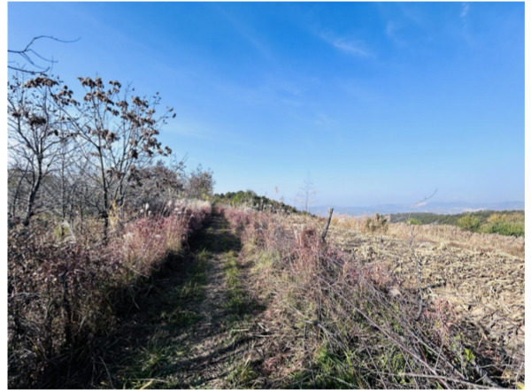
新建道路现状
