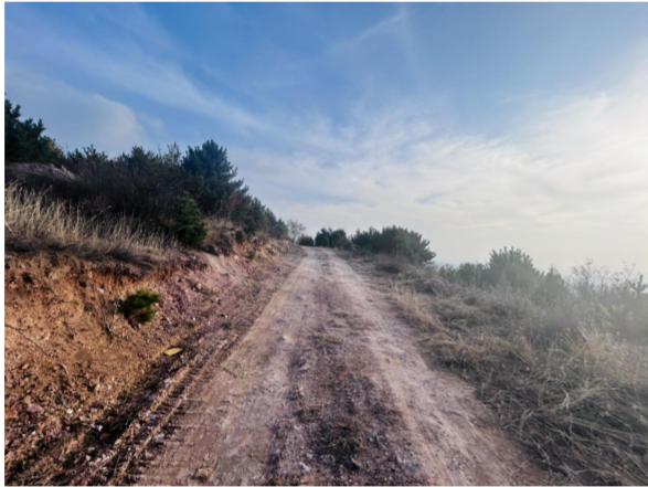
改建道路现状
